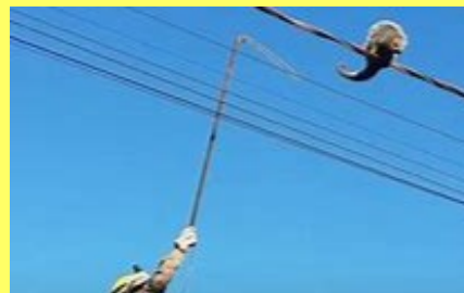
Animal sendo resgatado da fiação elétrica da rua
